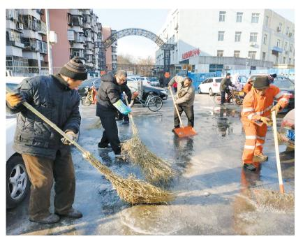
2019年1月1日上午10时30分,和义街道办事处门前绿化地下水管线爆裂,大量地下水涌出。街道城管科科长立即到现场维护秩序并指挥参与抢险工作,城管科其他同志以及社区志愿者共同到场协助抢险,同时南苑绿化队、自来水集团也到场参与抢险工作,关闭阀门、排查漏水点。街道协调昊天昊保洁公司出动10余人次扫除现场积水,以免影响居民节日出行,并向积水路面施撒融雪剂12袋,防止路面结冰导致居民滑倒摔伤。
