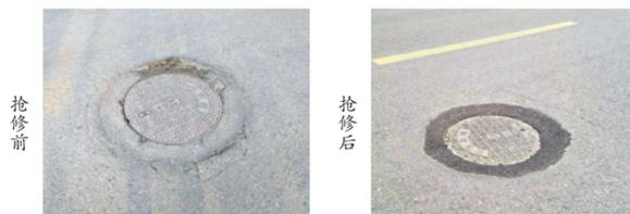
近日，市民拨打热线反映，槐房西路北向南方向范家庄北路路口，有个井盖塌陷3至5厘米，希望尽快处理。南苑乡接诉后，立即前往现场查看。该井盖属北信基础信息竖井，因井圈周边下沉，造成塌陷。南苑乡环境办、属地村积极组织力量，对塌陷部位进行抢修。市民对此表示非常满意。
