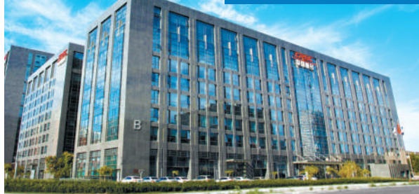
中国通号大厦实景图
