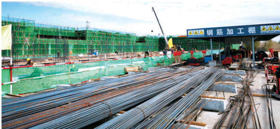
农副产品交易中心项目施工现场。赵智和/摄
