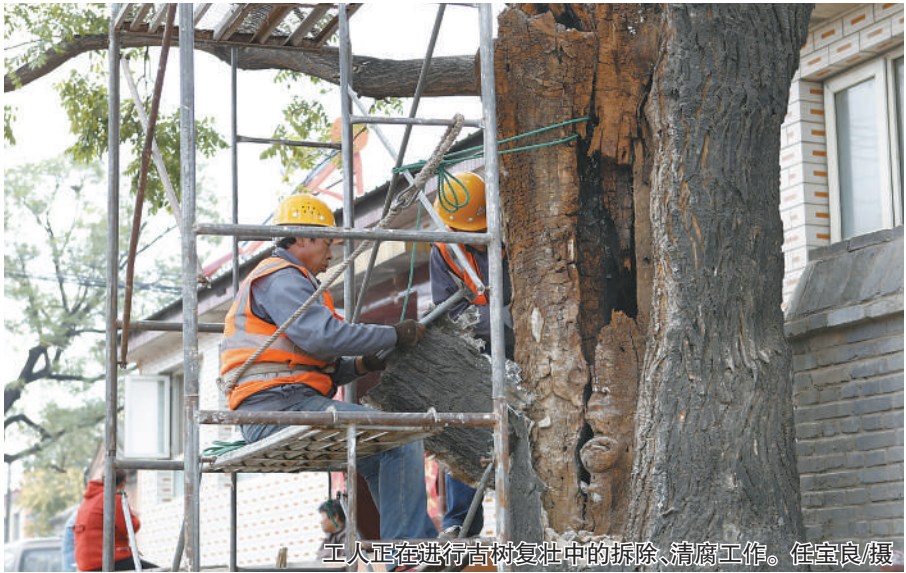
工人正在进行古树复壮中的拆除、清腐工作。傅宝良/摄
