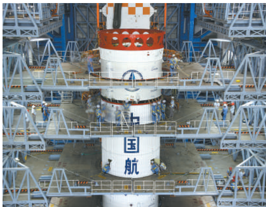
长五遥三火箭正在吊装。史啸/摄
