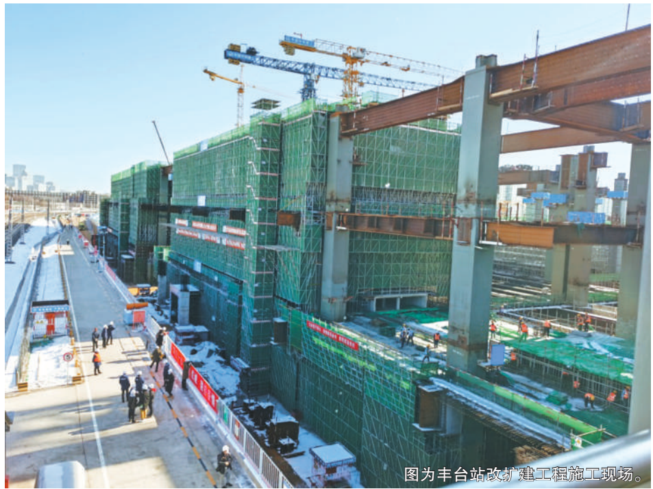
图为丰台站改扩建工程施工现场。
