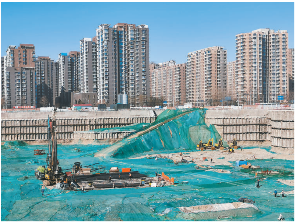
樊家村鼎业文化产业园项目复工现场。赵智和/摄
