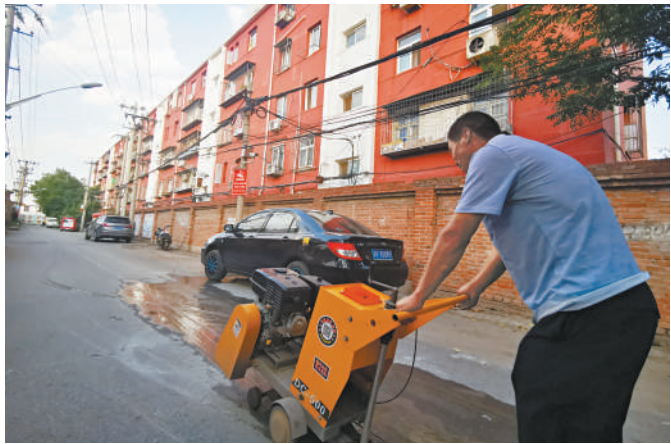
8月3日,南苑街道对槐房社区大泡子区域进行污水管线截污改造,改造后,将彻底解决大泡子区域300余户居民排污难题。
