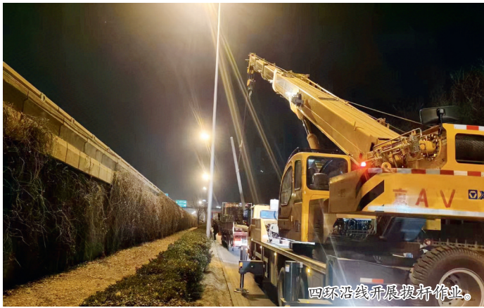
四环沿线开展拔杆作业。
