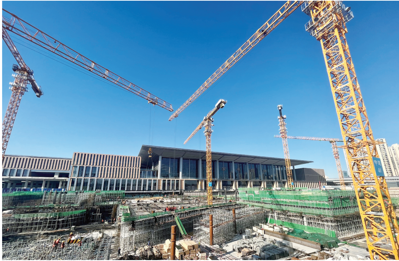
丰台火车站交通枢纽的建设现场。林瑶摄
