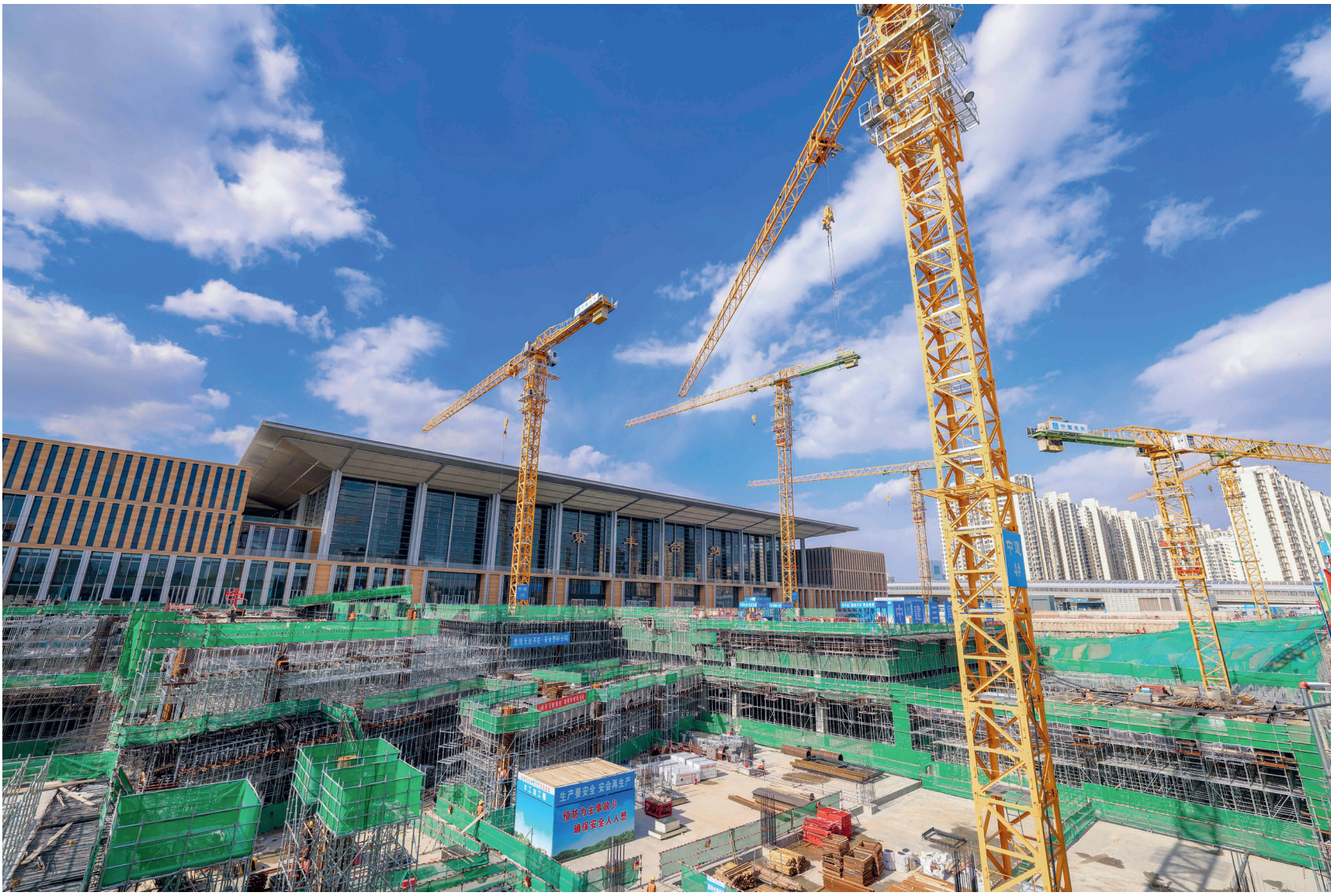
丰台站交通枢纽南枢纽实现首块作业区冲出正负零，“钻”出了地面，区域里最后1平方米的混凝土浇筑成型。潘之望 摄
