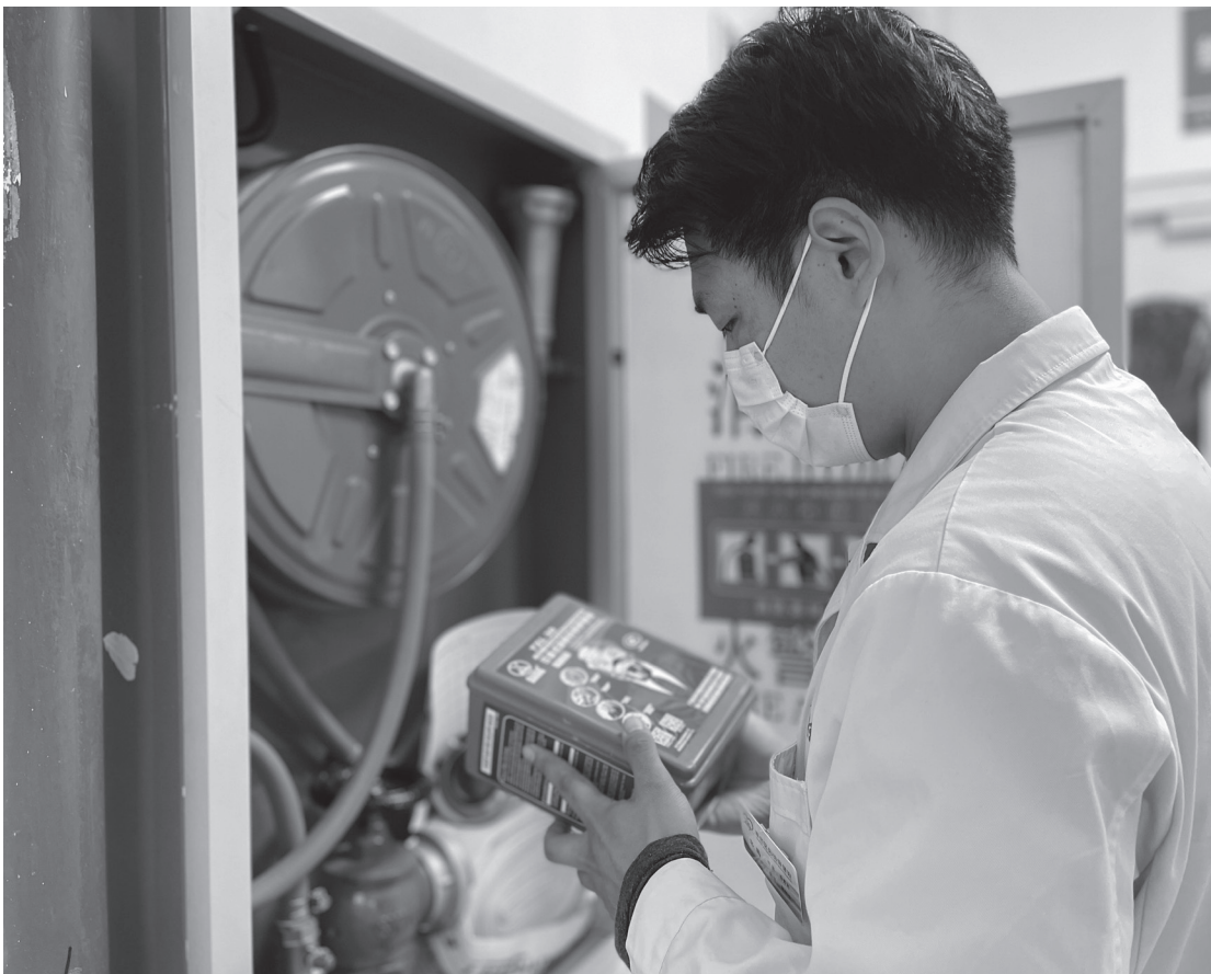
区妇幼保健院工作人员检查消防设施。
