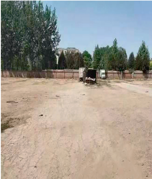
云岗变电站整改后。
