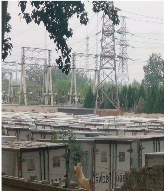
云岗变电站整改前。
