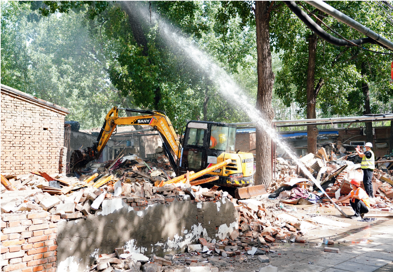
青塔街道已成功拆除违法建设108间，拆除面积2171平方米，疏解居民近百人。图为拆除现场。
