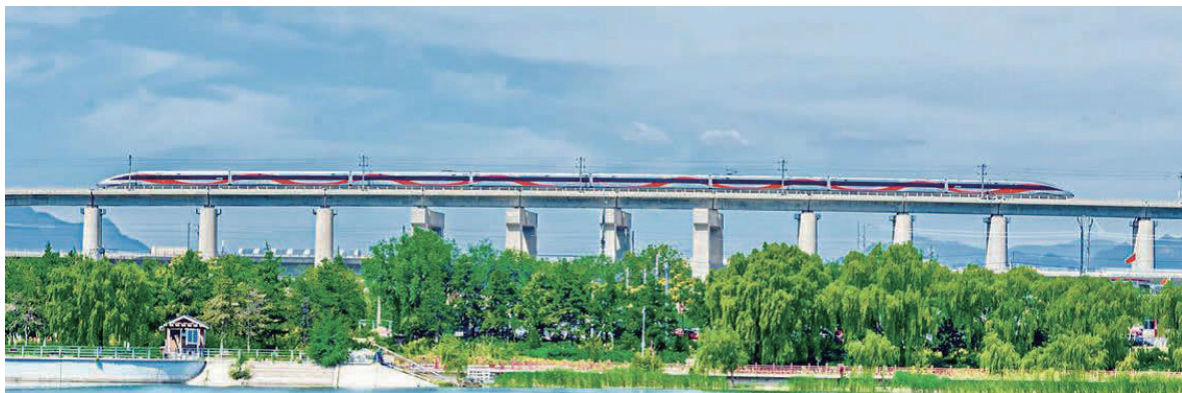
大力开展“三道工程”建设，依托“路道、河道、铁道”沿线空间，打造景色优美、环境宜人的“绿道、碧道、秀道”
