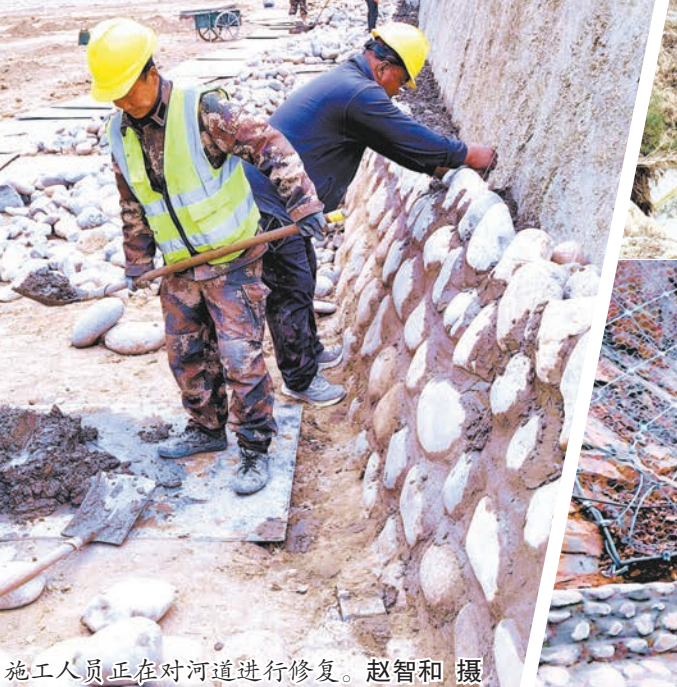
施工人员正在对山体护坡进行修复。赵智和 摄
