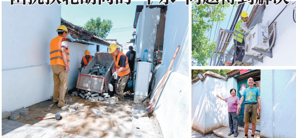
近日,长辛店街道陈庄社区扶轮胡同区域的居民盼来了综合整治提升,目前正在铺设雨水、污水管线和路面硬化、墙壁粉刷……困扰居民群众几十年的“下水”问题终于得到解决,这里的老平房区将旧貌换新颜,居民群众将开启“幸福生活”。赵智和 摄 (详见03版)
