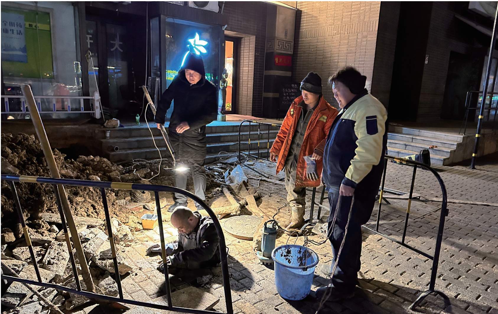
维修人员连夜维修管道。 张昕悦摄
