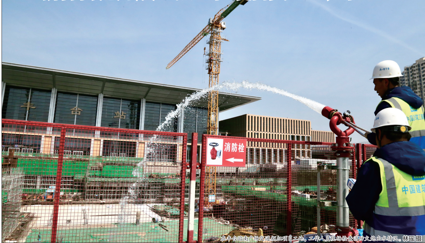
在丰台站南广场交通枢纽项目工地,工作人员现场检查消防水池出水情况。林瑶摄
