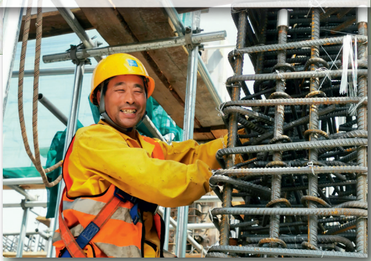
工人在中央芭蕾舞团业务用房扩建项目工地施工。 李倩倩 摄
