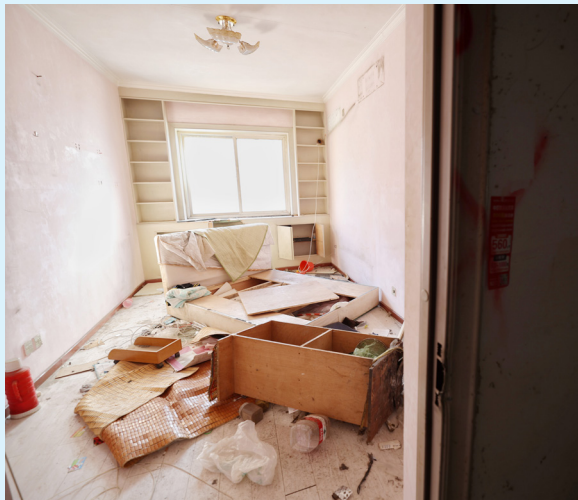
楼内居民已经搬走。 特约记者 陶冉摄
