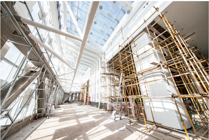
北京口腔医院迁建工程施工现场。原梓峰 摄
