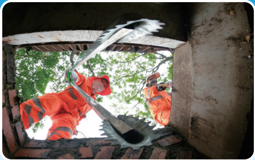
▼环卫工人正在西南四环科丰桥南清理排水井。
