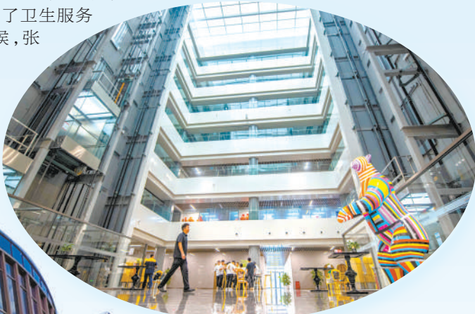
改造后的办公楼天井打通,增加了楼内的采光。特约记者 潘之望 摄
