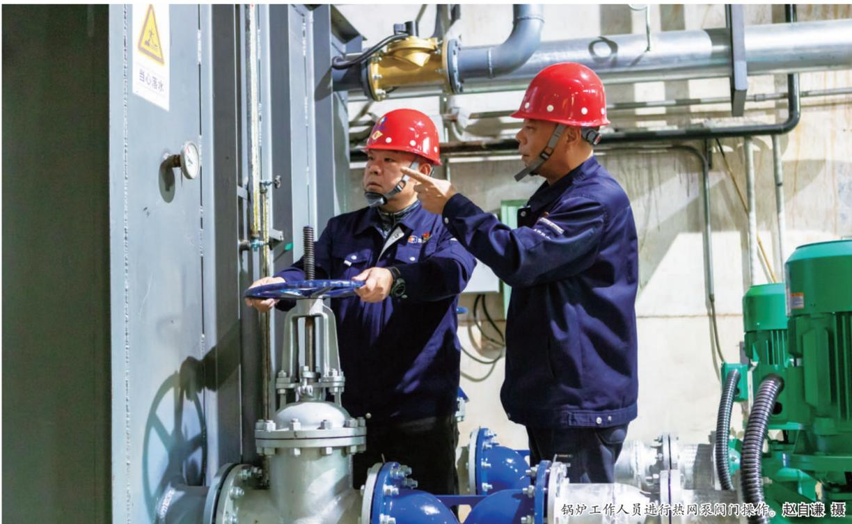
锅炉工作人员进行热网泵阀门操作。赵自谦 摄
