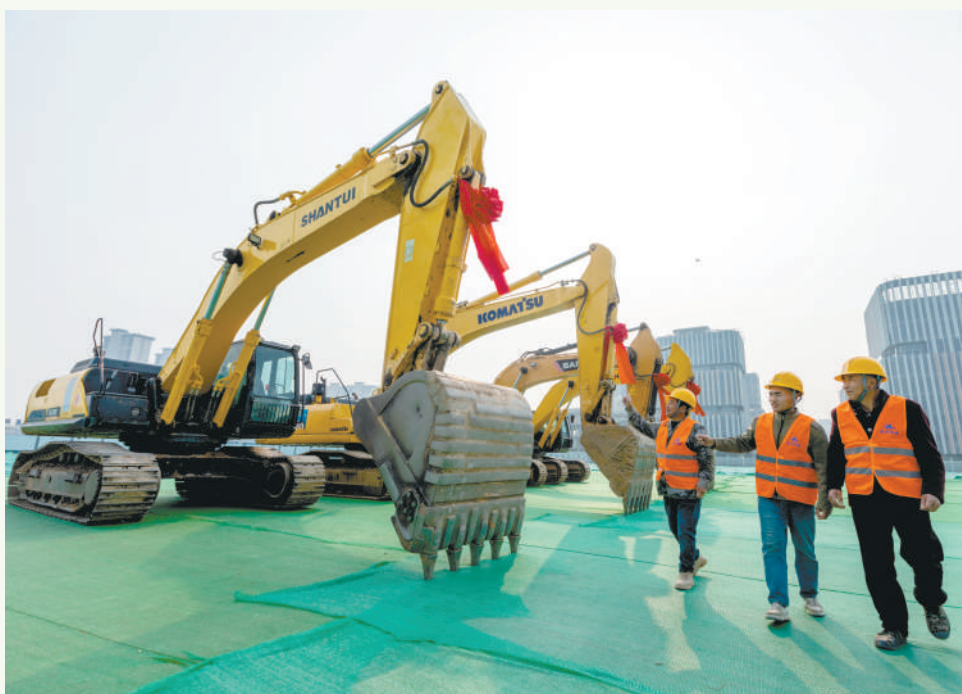
北京园博数字经济产业园创新中心二期项目开工,开工奠基仪式现场,大型工程设备整装待发。赵自谦 摄
