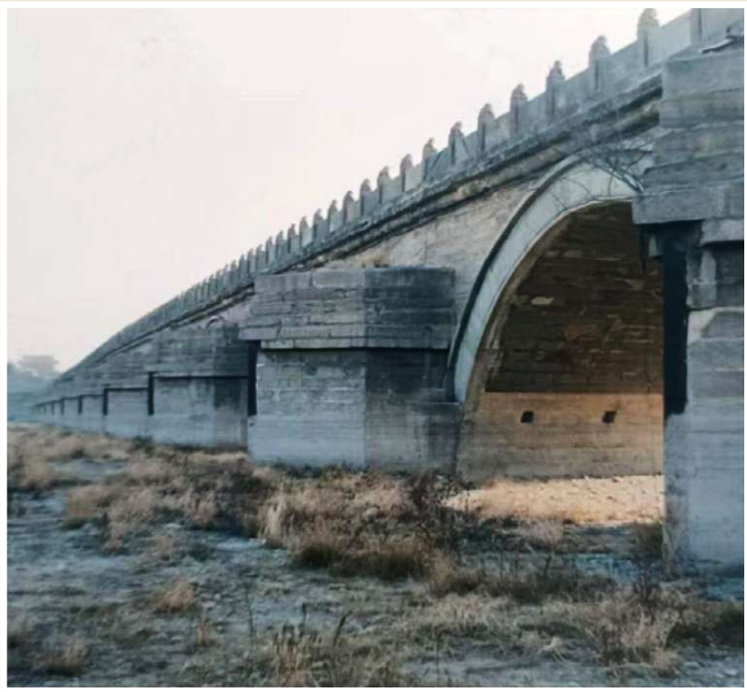
卢沟桥桥墩上的“斩龙剑”
