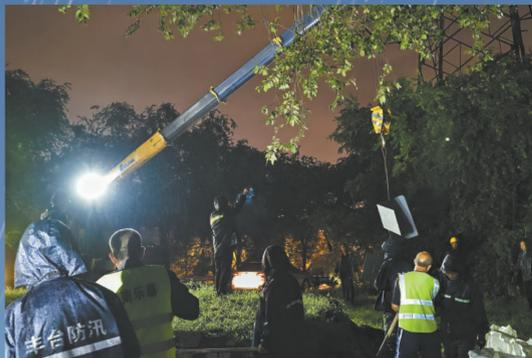
区水务局工作人员指挥吊车吊起铁板加固墙体。
