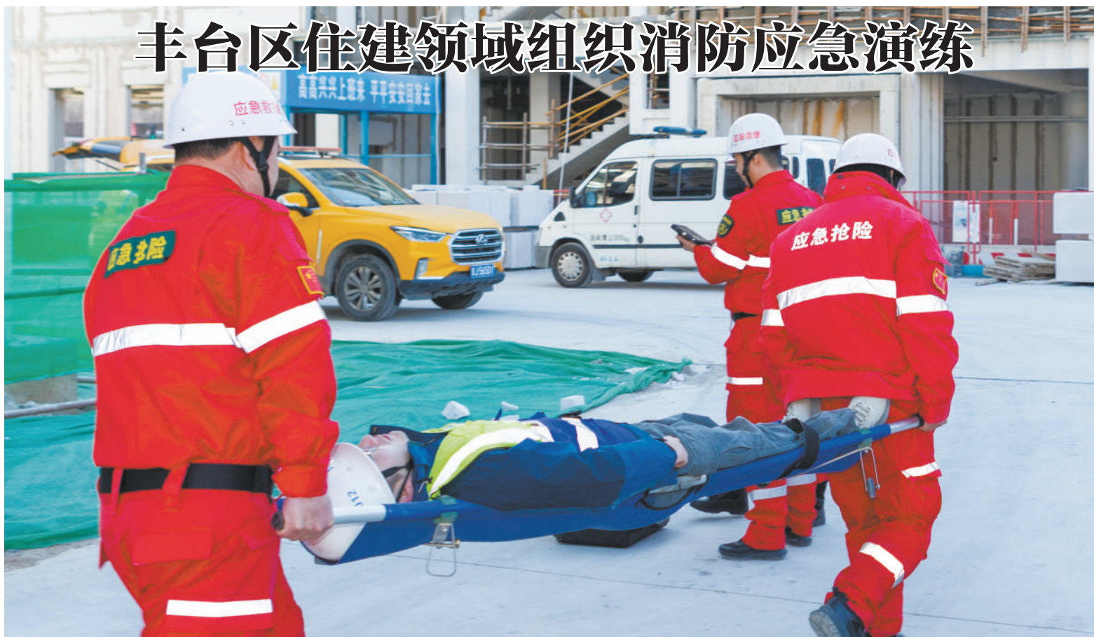
11月25日,丰台区住建领域在北京市十二中河西分校新建项目工地组织“消防宣传月”暨消防应急演练活动。活动紧紧围绕全国第34个“119”消防宣传月“全民消防、生命至上——安全用火用电”主题,推动住建系统安全责任落实,坚决防范和遏制安全事故发生。
