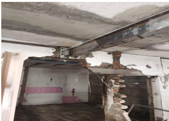
（事故现场残存部分加装钢梁的情况）
